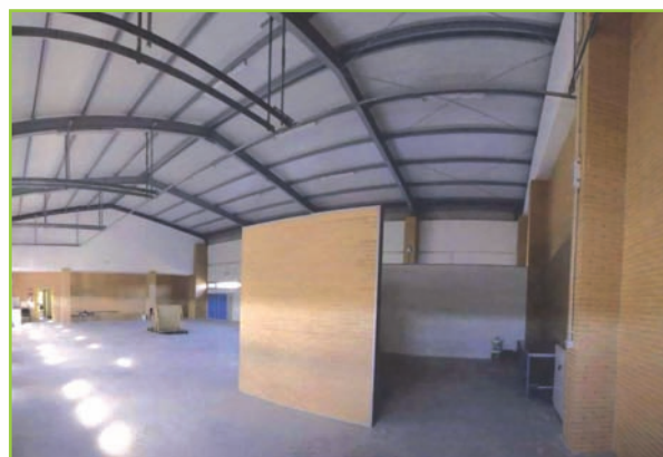
Obras de acondicionamiento de un parque.
