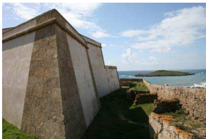
Figs. 15.- Sines. Aspecto do forte do Pessegueiro, com a ilha ao fundo
