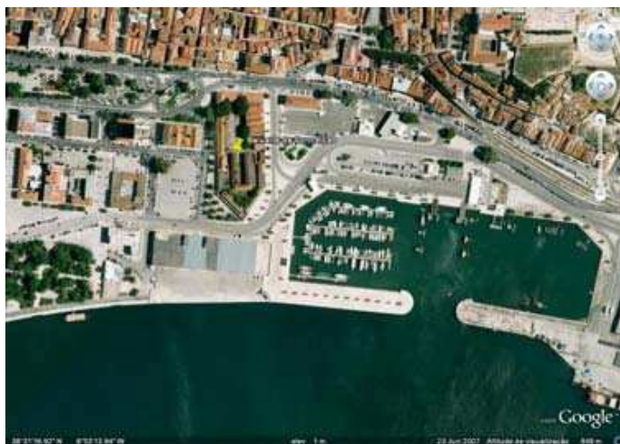
Figs. 10. -Setúbal. Localização do antigo baluarte da Conceição e do cais, no seu aspecto actual. Devido a aterro da margem, o baluarte não confina hoje com o rio.
