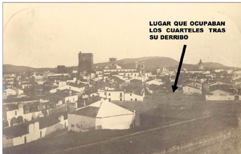
Lugar que ocupaban los cuarteles, con todo el espacio aun libre de edificaciones tras el derribo. Foto de principios del s. XX
